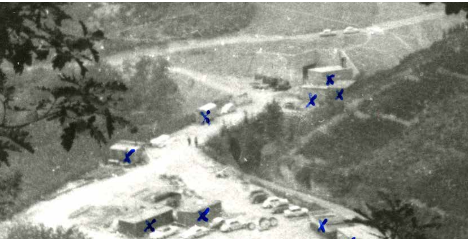
Zugang Ost-Ost in den Ahrweiler Regierungsbunker (1966; heutige Dokumentationsstätte): Auch hier dokumentiert die DDR-Spionage Baufortschritt und Außenbauwerke - teilweise etwas zu kreativ, denn die blauen Kreuze kennzeichnen Tarnbauten. Tatsächlich sind es Baucontainer oder Baracken.
