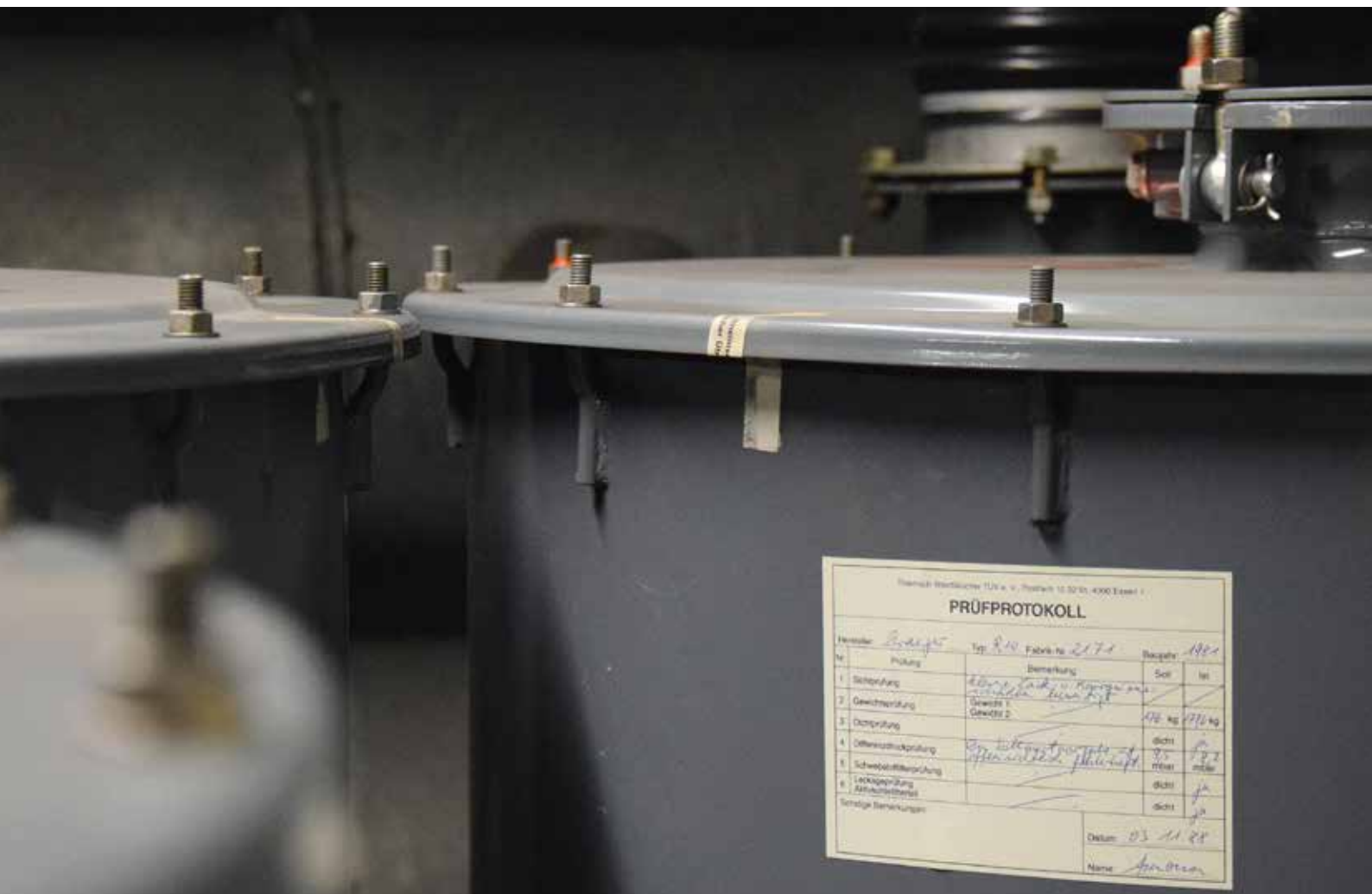
Letzmalige Prüfung der Luftfilter 1988. Diese Mehrzweckanlage in Alzey (Tiefgarage) steht stellvertretend für den Umgang mit Schutzbauten nach Ende des kalten Krieges. Ernsthafte Bemühungen um den technischen Erhalt und die Einsatzfähigkeit blieben aus. Nach über 30 Jahren Stillstand nun über Reaktivierungen nachzudenken, ist fern aller Bunker-Realitäten.
